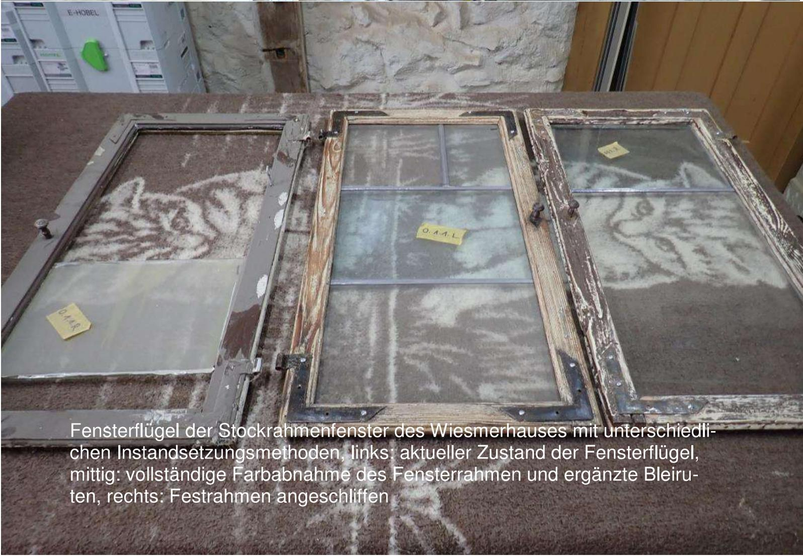
Fensterflügel der Stockrahmenfenster des Wiesmerhauses mit unterschiedlichen Instandsetzungsmethoden, links: aktueller Zustand der Fensterflügel, mittig: vollständige Farbabnahme des Fensterrahmen und ergänzte Bleiruten, rechts: Festrahmen angeschliffen
